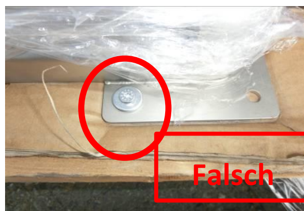
Abbildung 4: falsche Befestigung mit Schrauben
